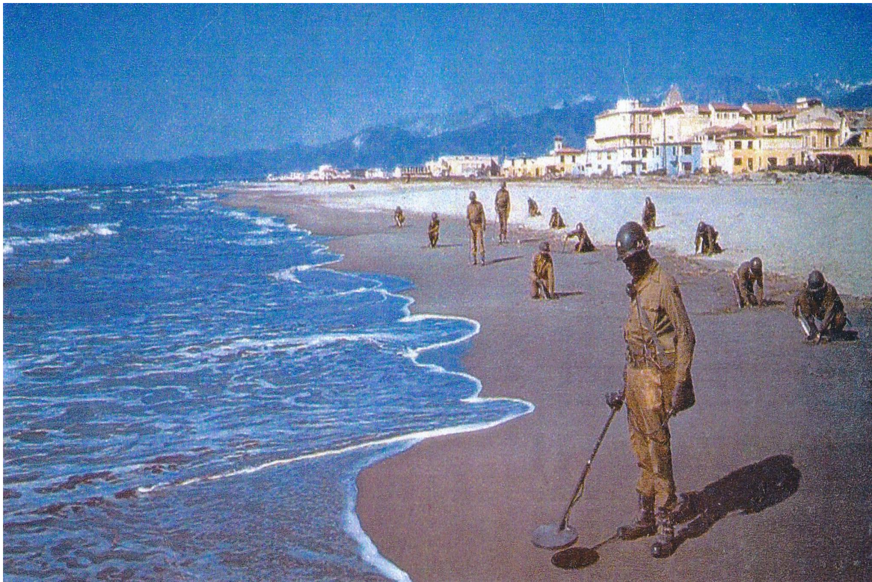
GLI SMINATORI DELLA BUFFALO CON IL METAL DETECTOR CERCANO LE MINE TEDESCHE TELLER 43, DETTE DAI VIAREGGINI PADELLE
